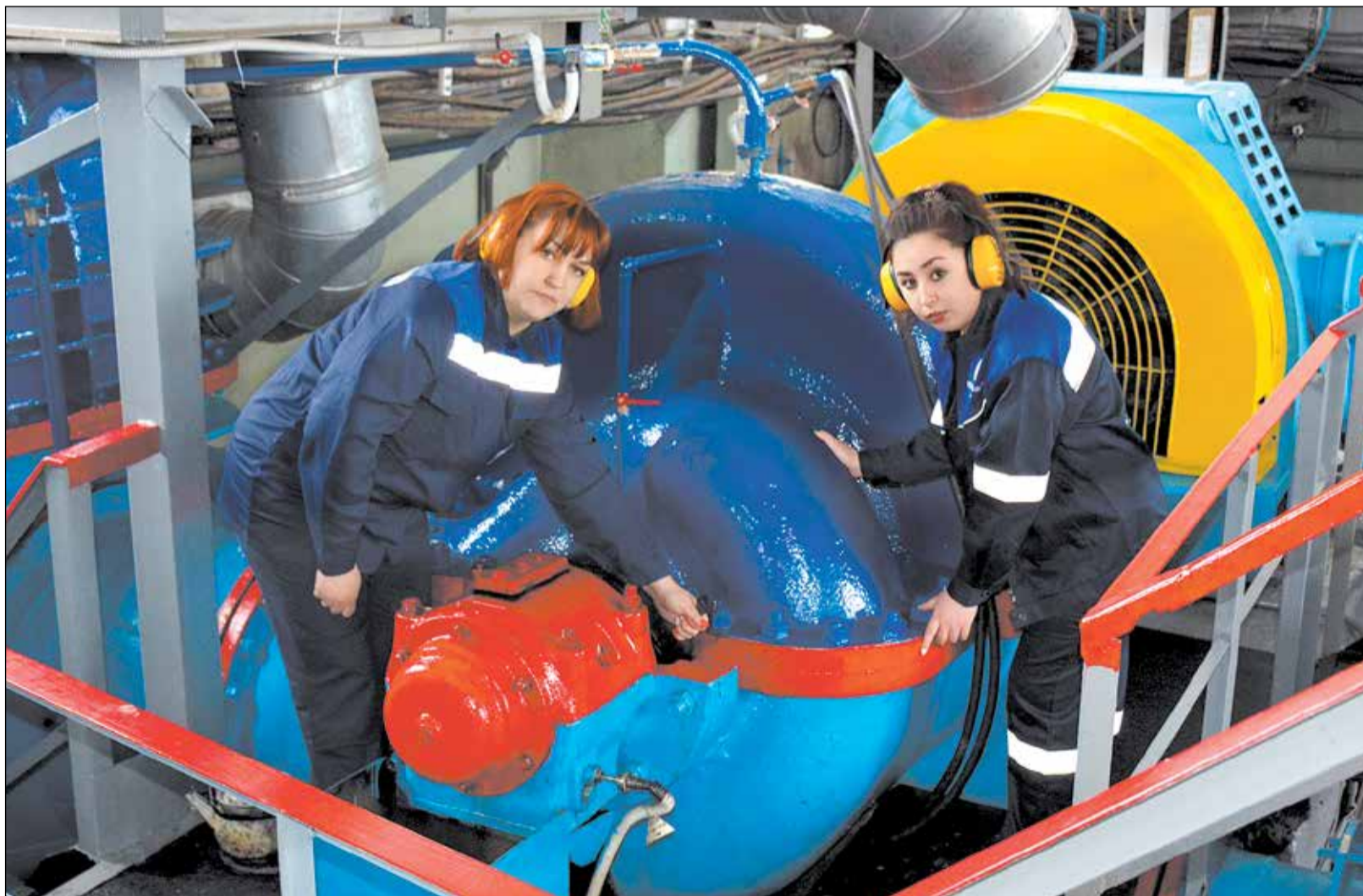
Уполномоченный по охране труда профкома Элина Тухтаметова с мастером насосной станции № 5 цеха эксплуатации водопроводных сетей и сооружений Вераникой Вдовиченко осматривают рабочие места.
