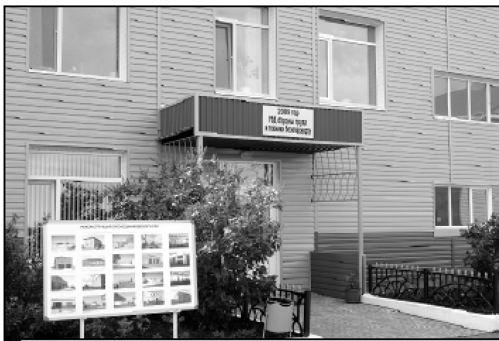
Так теперь выглядит здание Окешниковского РЭС. В нынешнем году завершена полная реконструкция этого структурного подразделения «Омскэнерго».
