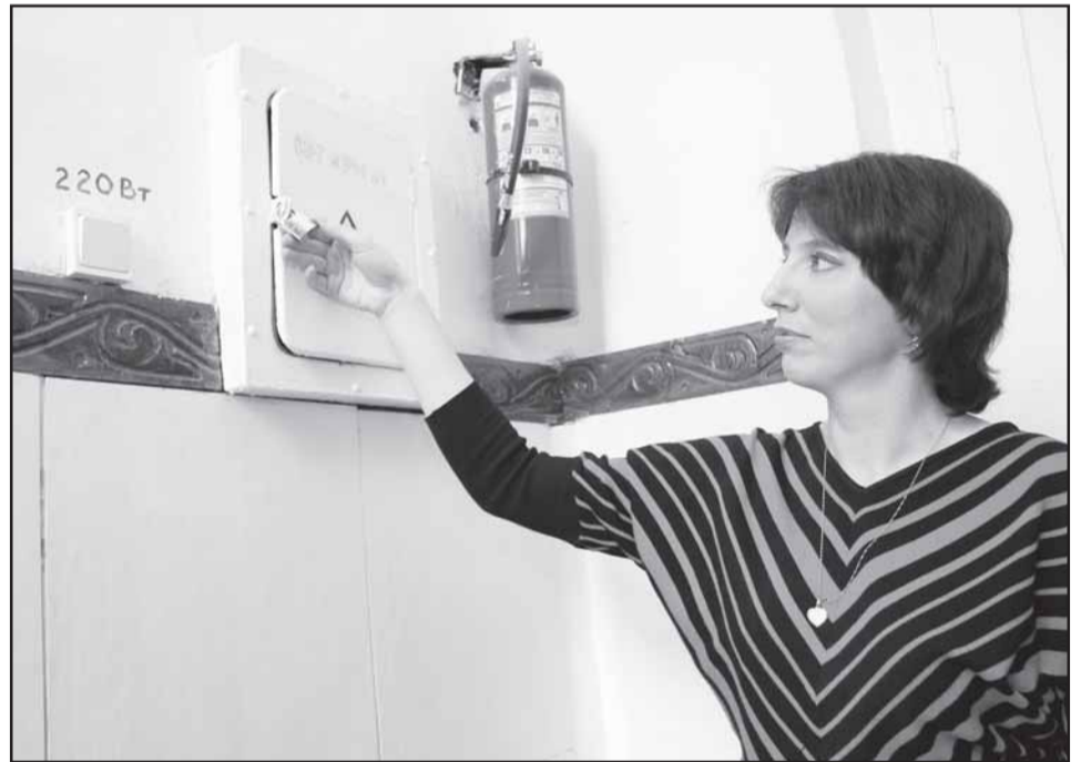
Уполномоченный по охране труда Ольга Винклер проверяет состояние оборудования противопожарной безопасности.
